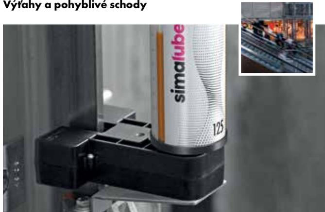
125 ml maznica simalube maže vodiace profily výťahov a zabraňuje suchému treniu. Mazací systém je pripevnený priamo na strechu kabíny.
