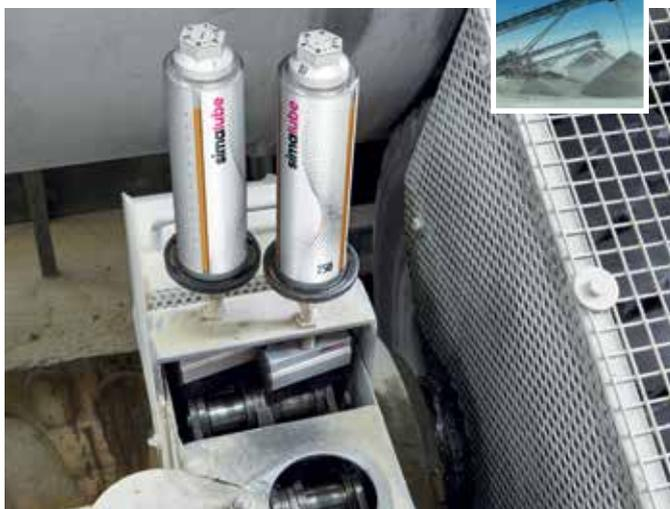
2 maznice simalube 250 ml s kefkou zabezpečujú čistenie a mazanie refazového pohonu bubnovej práčky.
