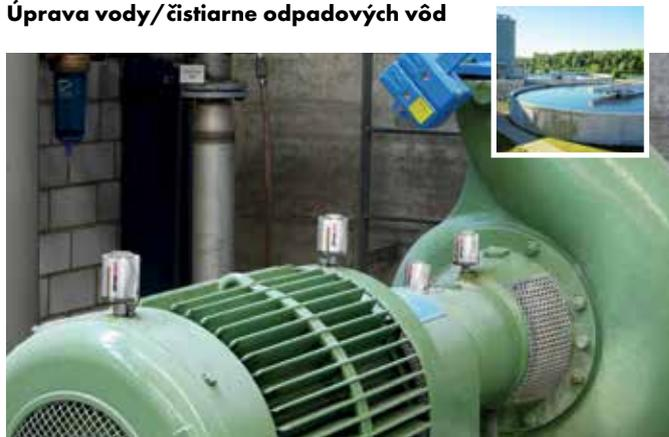
60 ml maznice na elektromotore a hnacom hriadeli zabezpečujú nepretržité mazanie odstredivého čerpadla.
