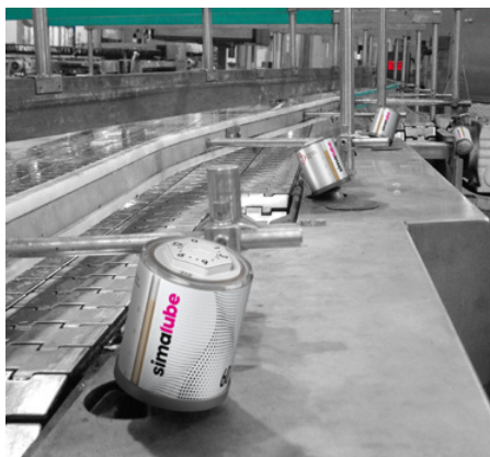
Plniaca linka vybavená niekoľkými maznicami simalube.
